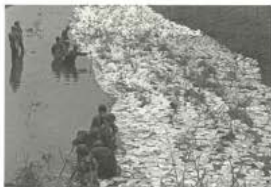
写真2 マジックファイバー現場使用時の様子
